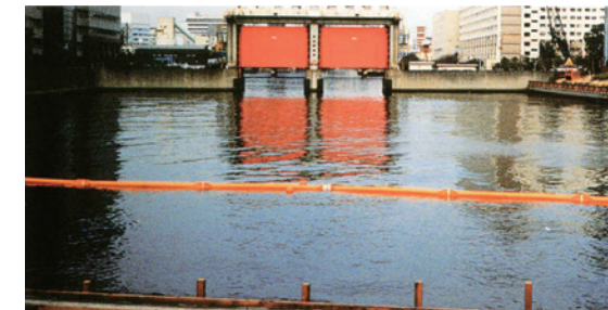
展張されたダストフェンス
